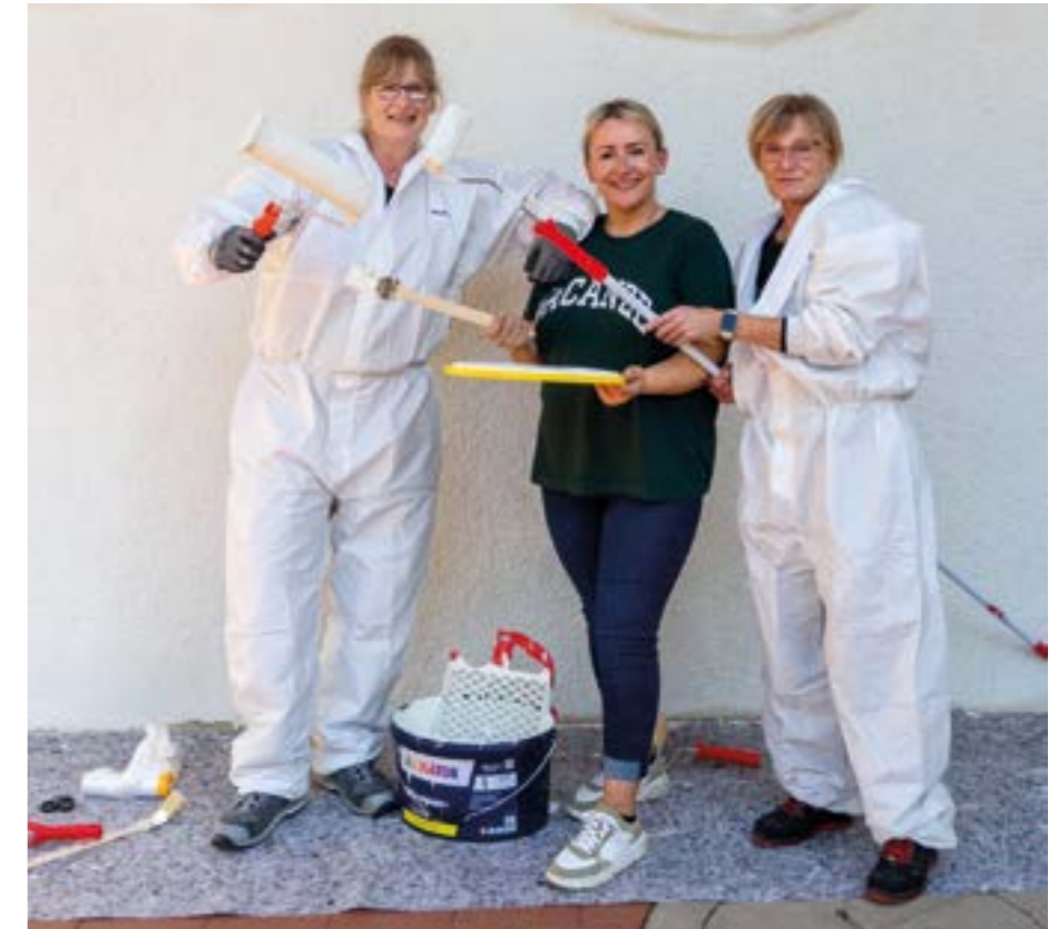
Malerarbeiten an der Außenwand der Ostschule wurden von einem Damenteam erledigt
