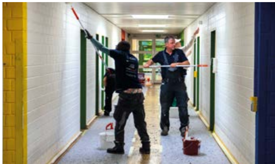
Die Flure im Gebäude von eeWerk werden gestrichen
