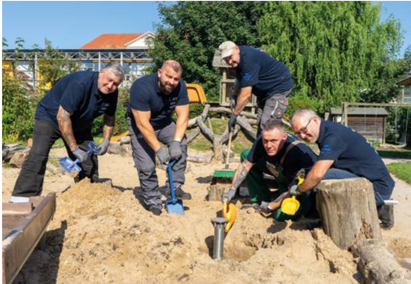
Arbeiten auf dem Sandspielplatz der Kita in der Stiftstraße
